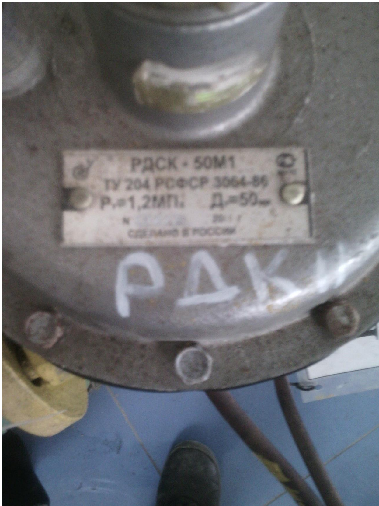
Фото 2. Регулятор давления газа РДСК-50 М1
